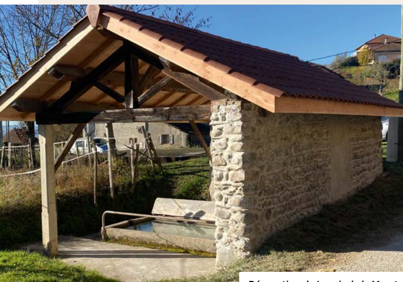
Rénovation du Lavoir de la Murat
