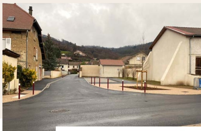
Les travaux se terminent au carrefour de la bascule
